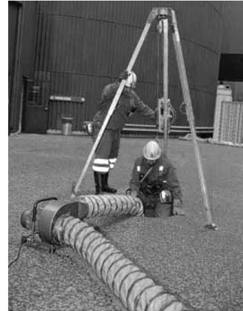
Beim Einsteigen in einen Schacht ist Alleinarbeit verboten. Denn im Notfall (Erstickungsgefahr!) ist sofortige Hilfe nötig. Die einsteigende Person muss dauernd von einer zweiten Person überwacht werden.
